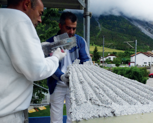
Un mortier-colle est appliqué sur toute la surface de l'élément coupe-feu.
