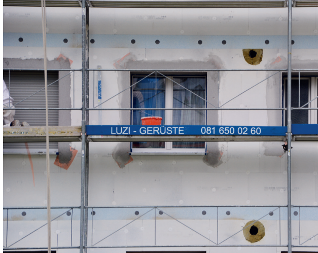
Vue d'éléments coupe-feu en place pour chaque étage.
