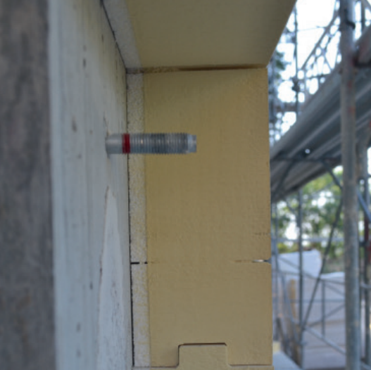
swissporEPS, rainures et crêtes pour éliminer les ponts thermiques
