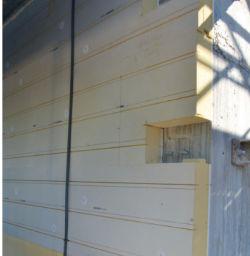
Raccord de pied de façade swissporXPS 300 SF / swisspor PUR Vento
