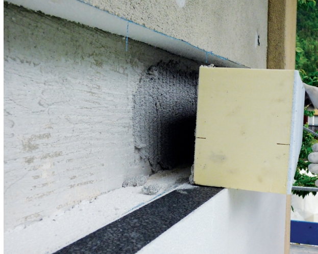
Mise en place de l'élément coupe-feu par le procédé du double encollage.
